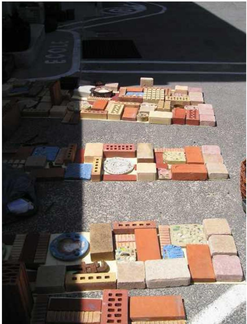
Le parement des deux piliers qui délimitent l'enceinte du mur sont préparés au sol avec les élèves. Un pavage des différents éléments est réalisé pour chaque face. Il s'agit d'équilibrer l'usage des matériaux disponibles. Lors de la pose se posera le problème des arêtes et nous ne pourrons pas finalement respecter totalement nos choix du début.
