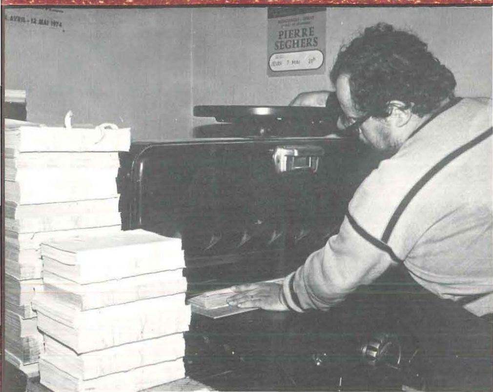
Coupe du livre au massicot Réalisation des mors à la machine à rouleau
