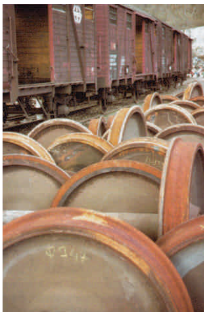
Chantier de démolition de wagons SNCF
