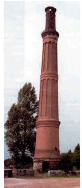
Cheminée avec ornements d'une ancienne briqueterie du Lot
