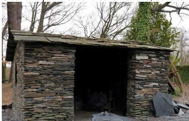
Cabane de fendeur, édifée en utilisant des pierres à déchets
